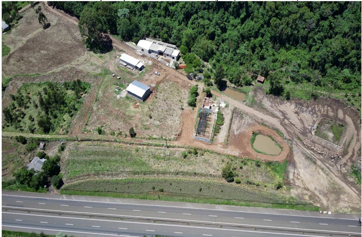
Entrada principal Área de Amortização (acesso RPPN)
